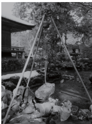
三千院庭園の修理状況
