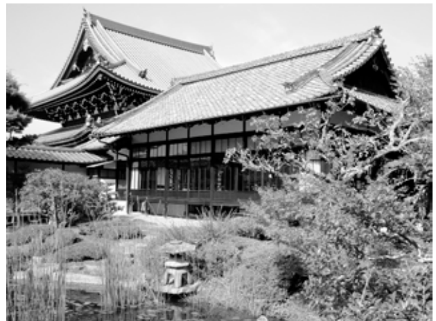
修理前の光雲寺庭園(東西側)
